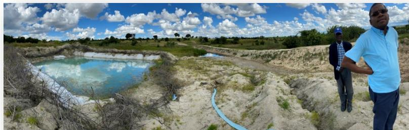
Ein Rückhaltebecken sammelt nachts das Wasser eines Baches. Am Tage wird damit ein Bewässerungssystem mit Motorpumpe gespeist.
